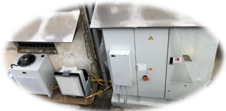
Przykład chłodzenia napędu/falownika
